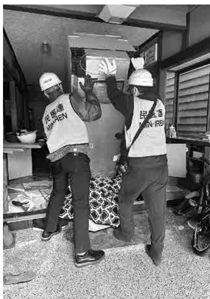
被災者の家から冷蔵庫を搬出する様子
